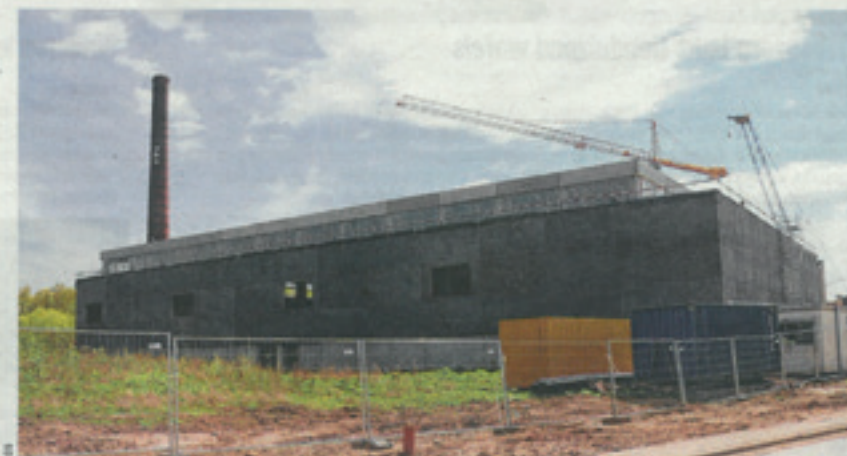
Van de vele oude fabrieksschoorstenen blijven er maar enkelen meer over. Deze toren wordt een klimtoren.
