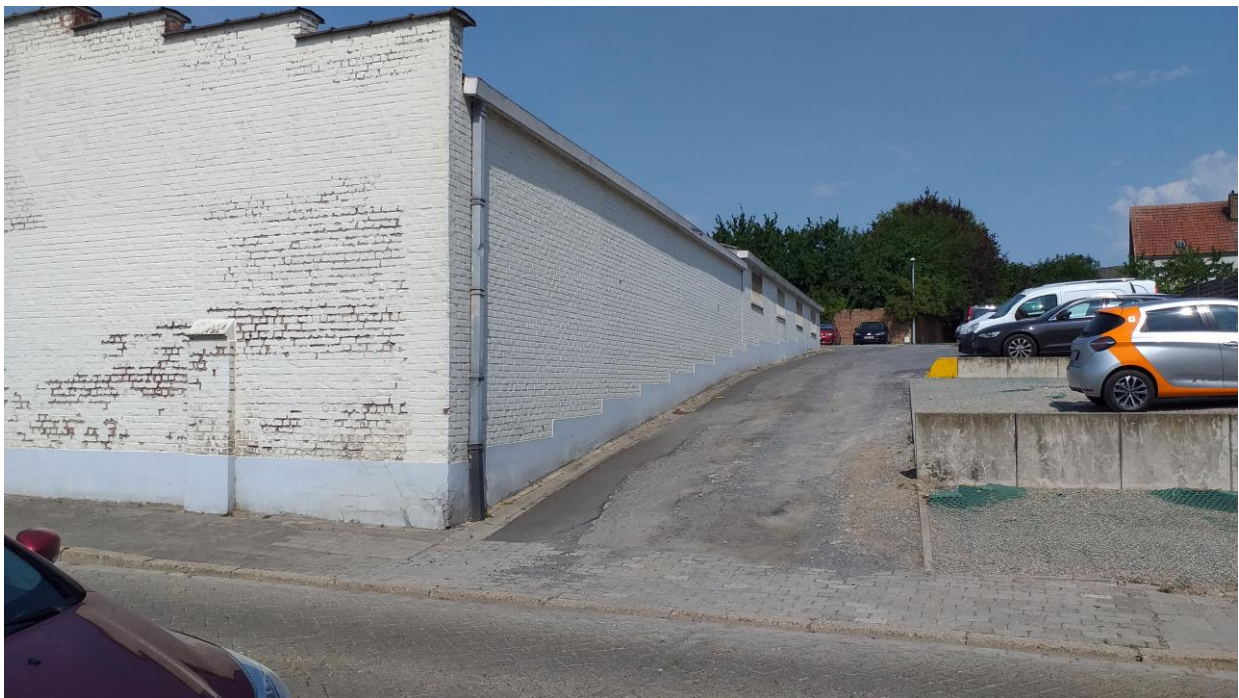
Foto 1: Zicht op het hoogteverschil van het projectgebied vanuit de Moreelstraat (bron: SOLVA)
