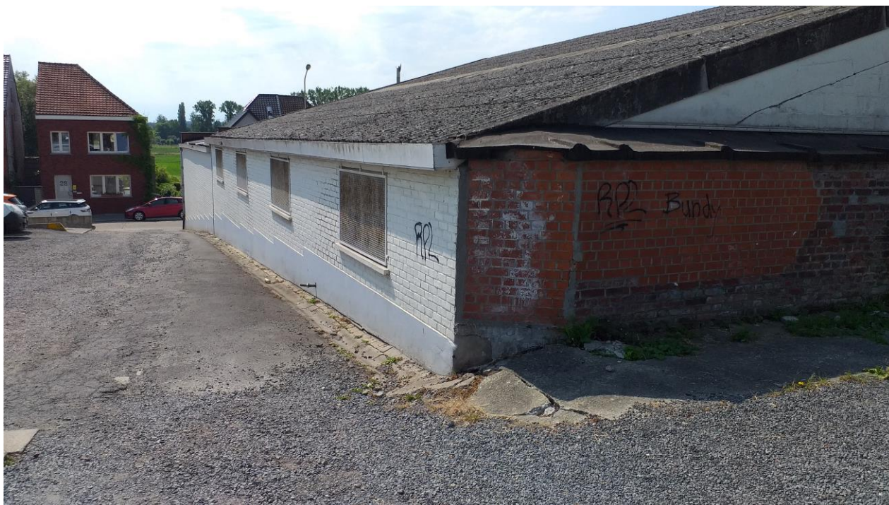
Foto 2: Zicht op het hoogteverschil op het projectgebied vanop de parking achteraan het projectgebied (bron: SOLVA)
